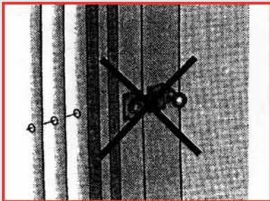
**NO COLOCAR** manivelas, pomos o cualquier tipo de cerrojos en el poste móvil, puesto que, al contener hilos y eslabones en su interior, podrían dañarse y ocasionar una importante avería.
